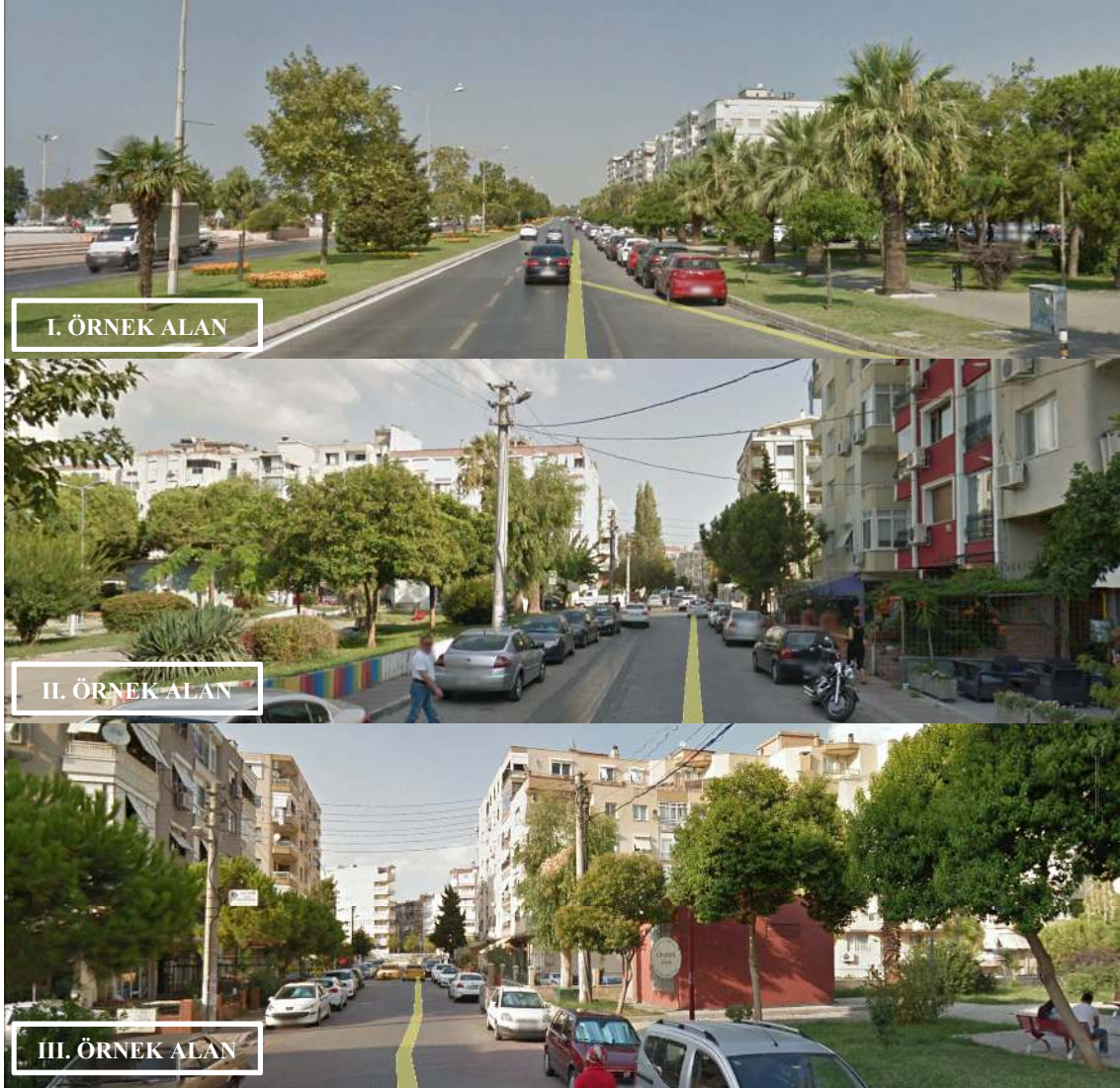
Şekil 8. Örnek alanların çevresindeki ve servis aldığı yol üzerindeki yapılaşmanın durumu [15]
